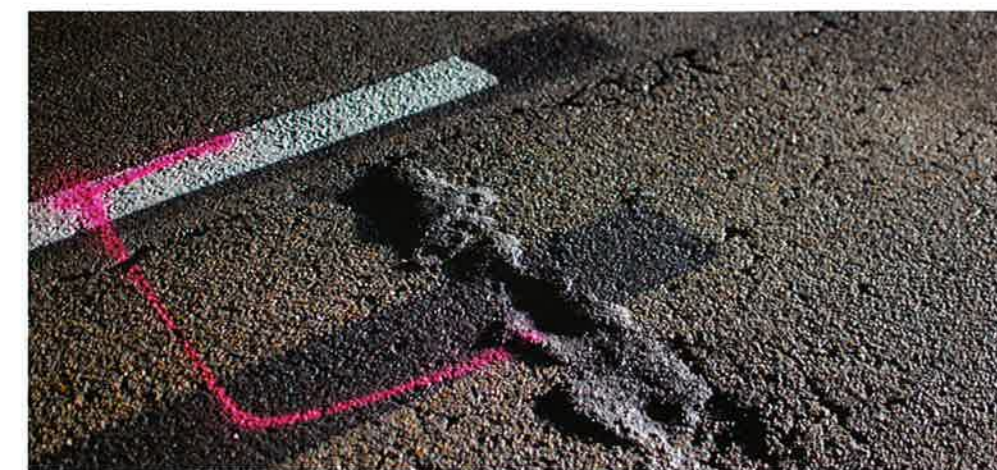
Les anomalies du bitume sont repérées et marquées en amont afin que l'opérateur, de nuit, puisse agir vite et offrir des cadences d'avancement remarquables.
