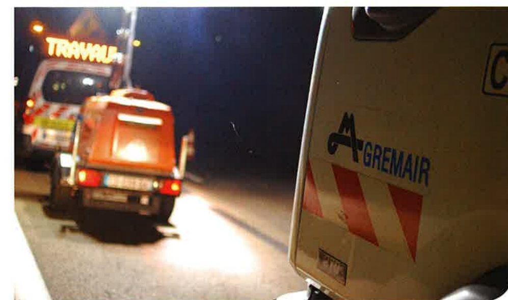
Sur ce projet, le convoi est limité puisqu'il se compose d'un groupe électrogène tracté par un véhicule léger, du camion Gremair et, cas particulier ici, d'un compacteur à rouleau qui ferme la marche.
